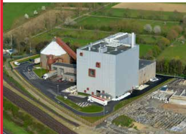
Chaufferie CRE Dalkia - Rennes (35)
