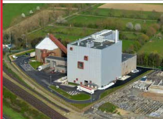
Chaufferie CRE Dalkia - Rennes (35)
