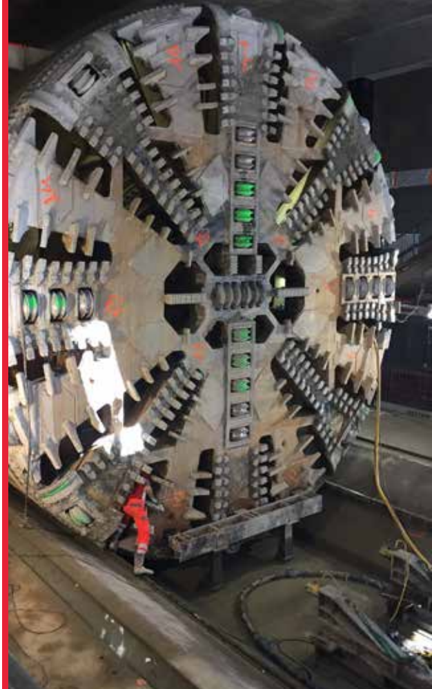
Ligne B du métro rennais (35) (Passage du tunnelier à la Station Jules Ferry)
