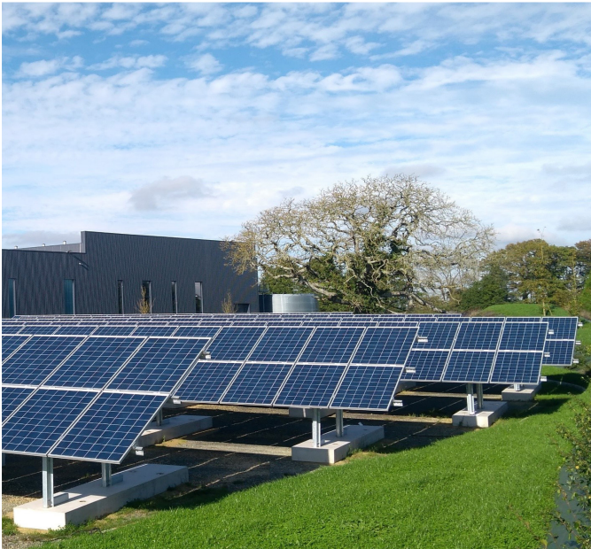
Locmaria - Lanvallay (22) - Centrale solaire au sol en autoconsommation - 75 kW
