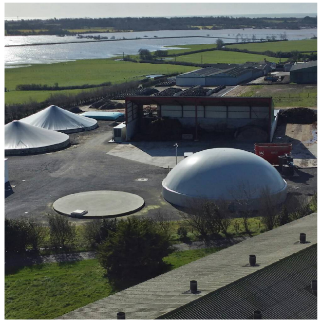
Maintenance de l'unité de méthanisation - L'Aiguillon-sur-Vie (85) - 220 kW
