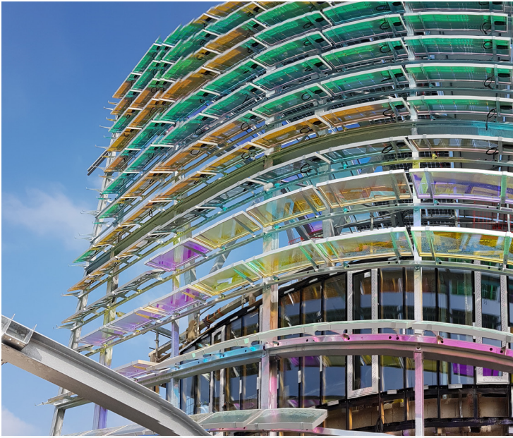
Hangar 108 - Rouen (76) - Toiture solaire en autoconsommation de 354 kW
