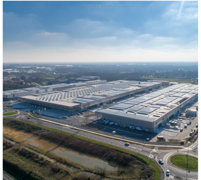
Marché d'Intérêt National Rezé (44) Toiture solaire de 5600 kW
