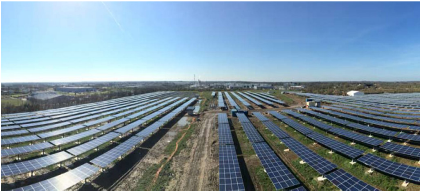
Centrale au sol - Le Poiré-sur-Vie (85) : Maintenance de l'installation solaire photovoltaïque - 5,2 MW
