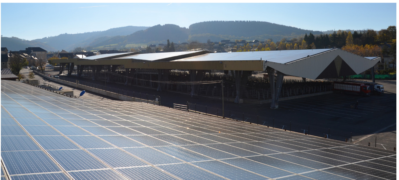
Marché aux bestiaux - Laissac (12) : Maintenance de la toiture solaire - 1,4 MW
