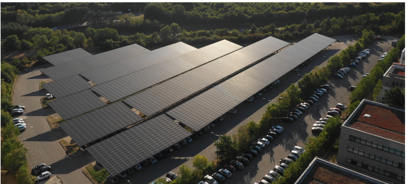
Zénith de Nantes Saint Herblain (44) Ombrières photovoltaïques de 2,5 MW
