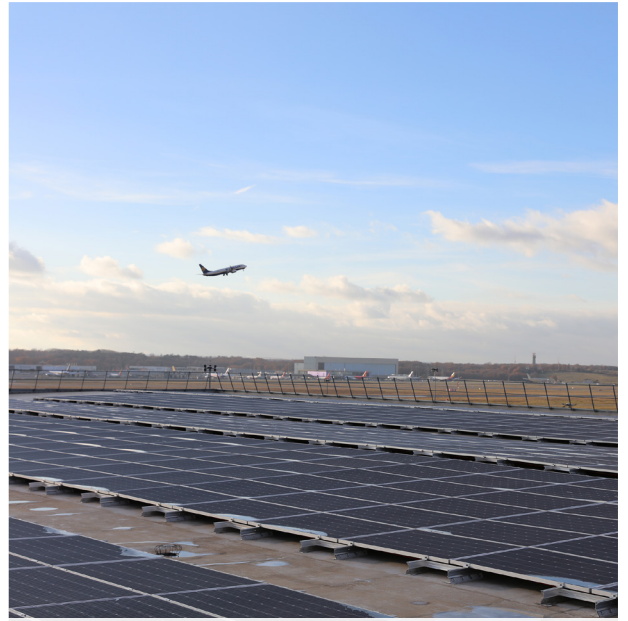
Aéroport Toulouse Blagnac (47) - Toiture solaire de 1000 kW
