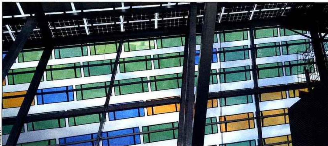
La sur-toiture colorée avec panneaux photovoltaïques dichroïques.
