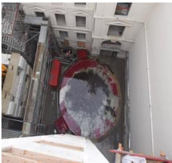
camions ne peuvent pas faire de marches-arrières. Dans le cas présent, le Groupe LEGENDRE l'a fait spécialement fabriquer par un prestataire spécialisé dans la réalisation d'outils pour les travaux et bâtiments publics : il se compose de plusieurs morceaux à assembler - un peu à la façon d'un camembert - avec deux moteurs qui l'entraînent.
