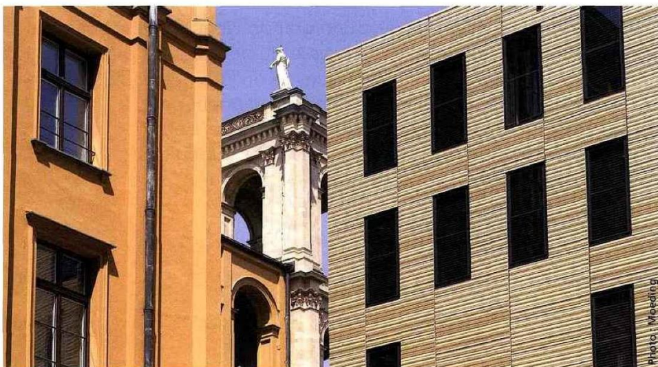
▲ La façade en bardeaux de terre cuite – Longoton de Moeding – de l'extension du parlement de Bavière fait écho, dans le choix des matériaux, des teintes et de leur texture, à la minéralité des bâtiments historiques environnants.
