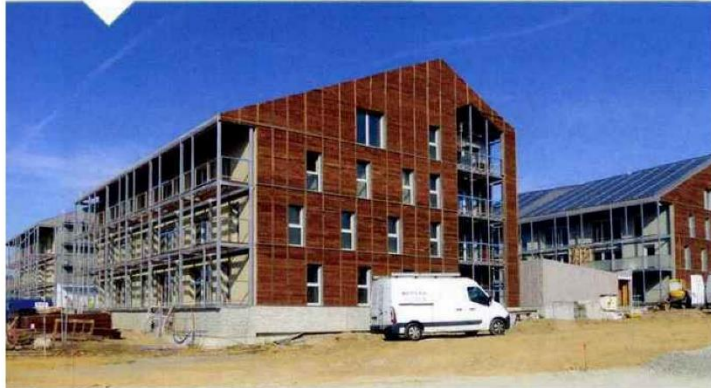
Les bâtiments Tempo en cours de finition.
