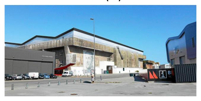
Situé dans le port de Lorient (56), le toit du bunker K2 de l'ancienne base sous-marine va accueillir 10 008 panneaux photovoltaïques d'ici la fin de l'année 2018, et ainsi produire plus de 3000 MWh par an qui seront directement injectés sur le réseau. Les travaux de ce projet, financé par la société XSea, ont été confiés à Legendre Énergie. Cette centrale solaire sera ainsi la plus grande toiture solaire de France en milieu urbain.
