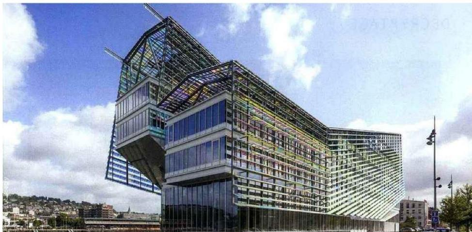
▲ Plus ouverte que la façade nord, la façade sud présente deux types de panneaux. Schématiquement, les dichroïques simples sont orientés à 5°, et les dichroïques photovoltaïques à 30°. La production électrique en façade est marginale par rapport à celle de la surtoiture.
