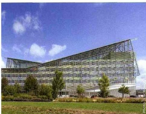
▼ La surtiture combine des panneaux photovoltaïques opaques de SunPower (327 W) et des panneaux ajourés d'Issal (95 W).
