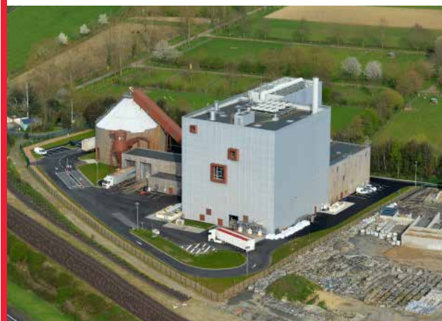
Chaufferie CRE Dalkia - Rennes (35)
