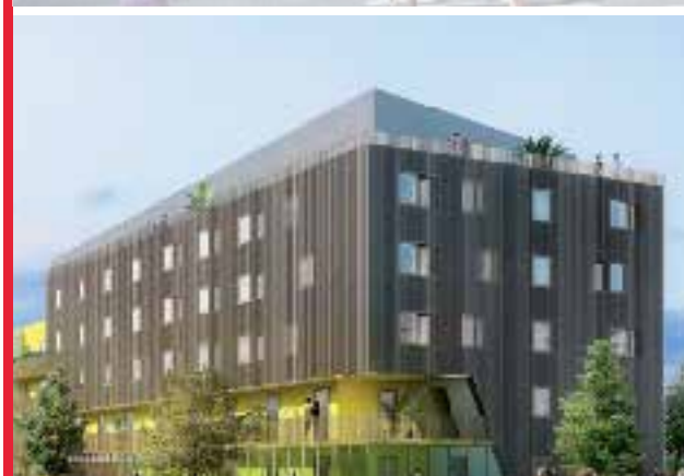
Immeuble de bureaux - Sevrans (93)
