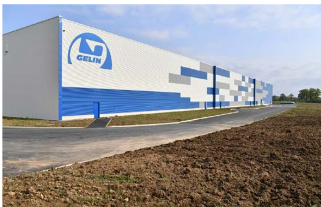
Plateforme logistique de Gelin – 18 000 m 2 - (35)
