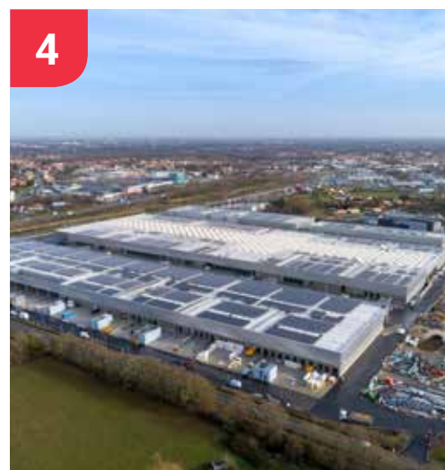
1. Aéroport de Toulouse-Blagnac - Toulouse (31) 2. Hangar 108 - Rouen Métropole (76) 3. Eau de Paris - L'Haÿ-les-Roses (94) 4. MIN - Nantes (44)
