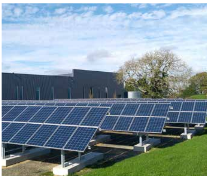
Locmaria - Lanvallay (22) - Centrale solaire au sol en autoconsommation - 75 kW
