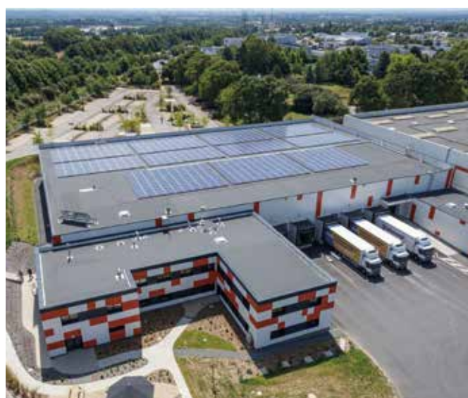
Biocoop - Melesse (35) - Toiture solaire en autoconsommation de 300 kW
