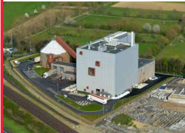
Chaufferie CRE Dalkia - Rennes (35)
