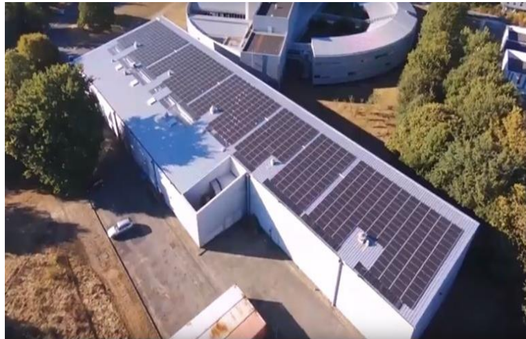
Halle d'essais de l'Ecole Polytech – Nantes (44)
