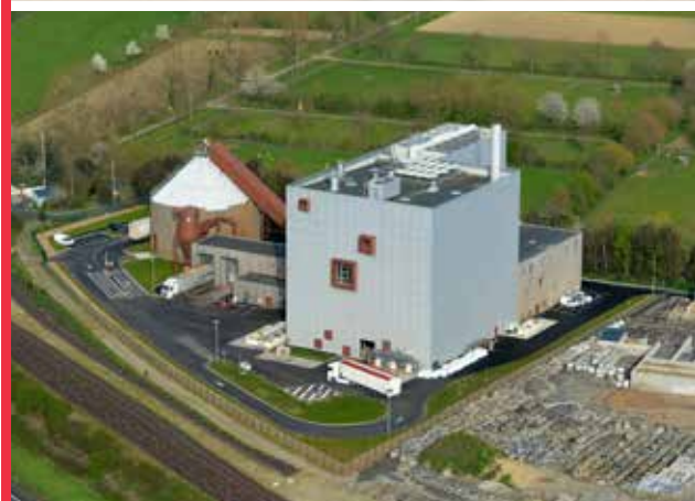
Chaufferie CRE Dalkia - Rennes (35)
