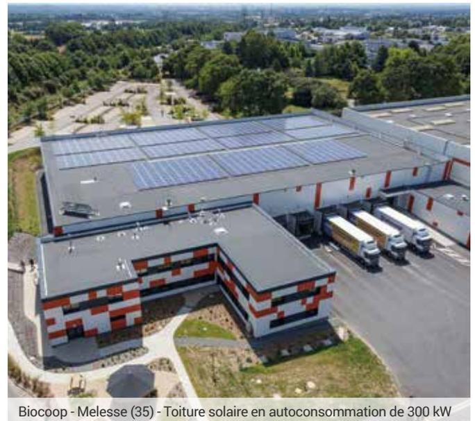
Biocoop - Melesse (35) - Toiture solaire en autoconsommation de 300 kW
