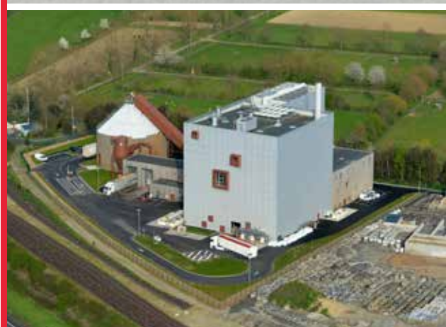
Chaufferie CRE Dalkia - Rennes (35)
