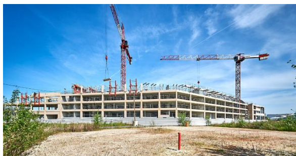
Travaux du parking de 440 places Legendre Immobilier
